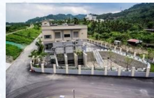
高雄旗山-溪洲抽水站
